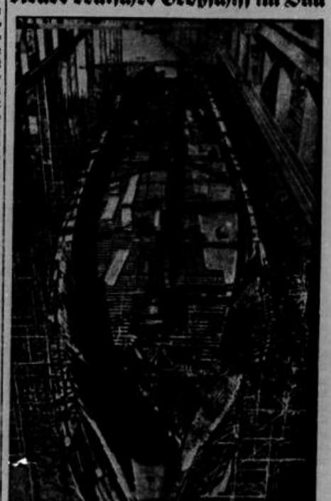
Auf der Hamburger Werft Blohm u. Voss wird für den Österreichischen der Hamburg-Amerika Linie der Doppelrumpfbauwagen „Potsdam“ gebaut, der 16 000 Registertonnen groß, 182 Meter lang und 22,5 Meter breit sein wird. Der Stapellauf kann voraussichtlich im Januar 1939 stattfinden.
